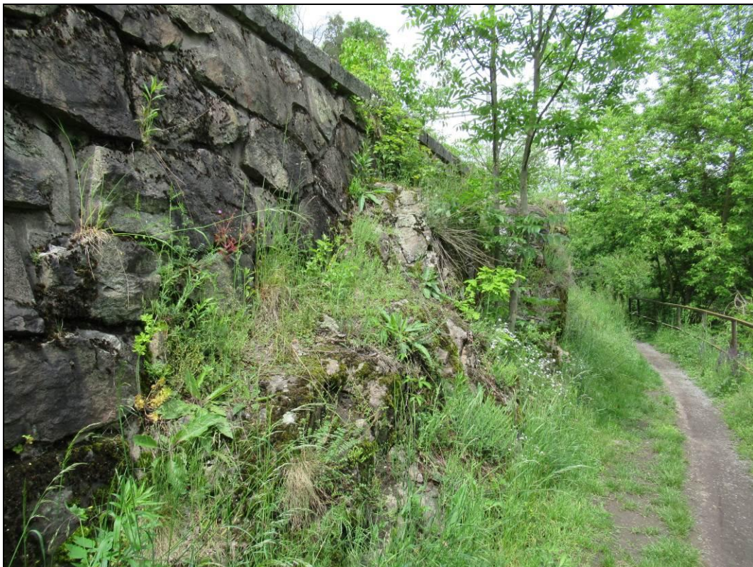
Obr. č. 16 - pohled na objekt opěrné zdi ve směru rostoucího staničení od km ca 165,190 do km ca 165,210. V této části je v lici OZ skalní výchoz a světlá výška OZ je proměnlivá.
