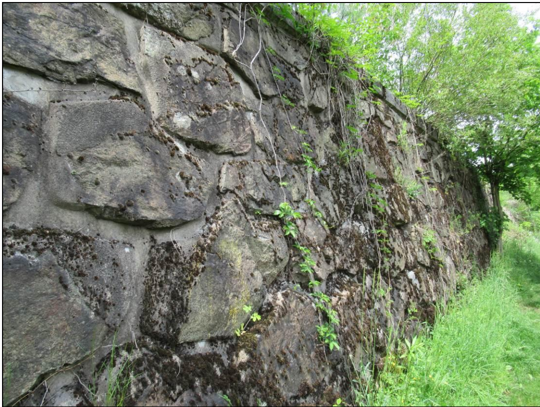
Obr. č. 15 - pohled na objekt opěrné zdi ve směru rostoucího staničení od km ca 165,160 do km ca 165,180. V této části je OZ tvořena pouze dřikem z kamenného zdiva.
