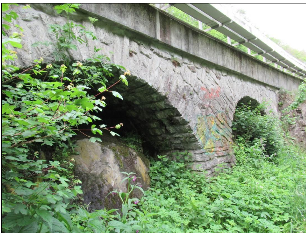
Obr. č. 18 - pohled na objekt opěrné zdi po směru rostoucího staničení od km ca 165,280 do km ca 165,300. Dřík zdi je zde tvořen dvěma klenbami z kamenného zdiva, které jsou zapřeny o skalní výchozy.
