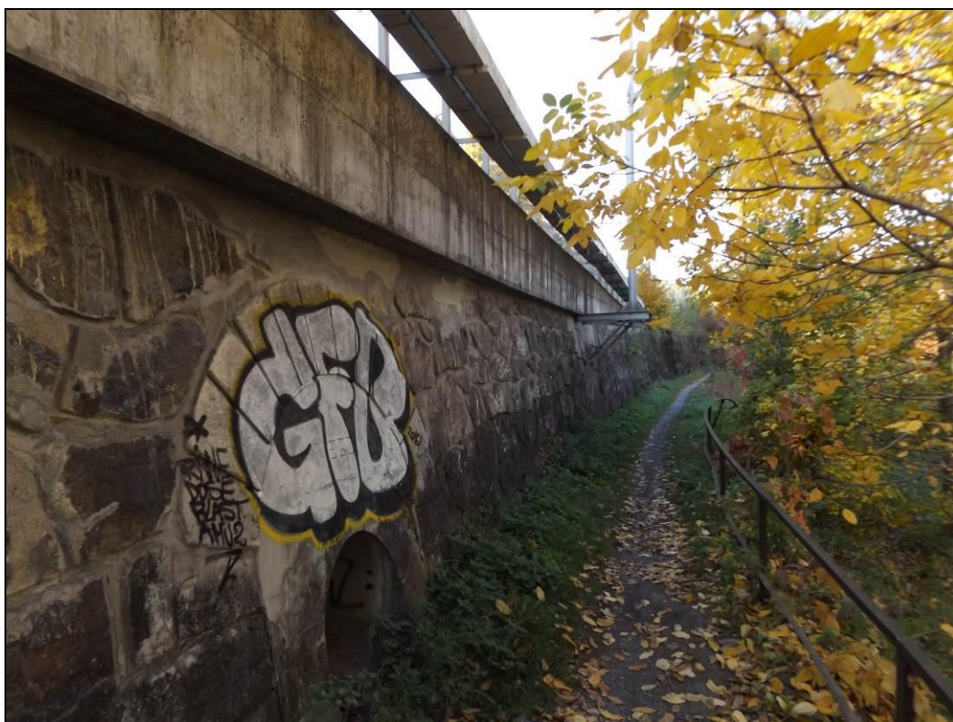
Obr. č. 14 - pohled na objekt opěrné zdi ve směru rostoucího staničení od km ca 165,120 (vlevo dole je patrný propustek v km 165,126) do km ca 165,170. V km ca 165,150 se OZ odklání od trati a dále betonová římsa v koruně nepokračuje.
