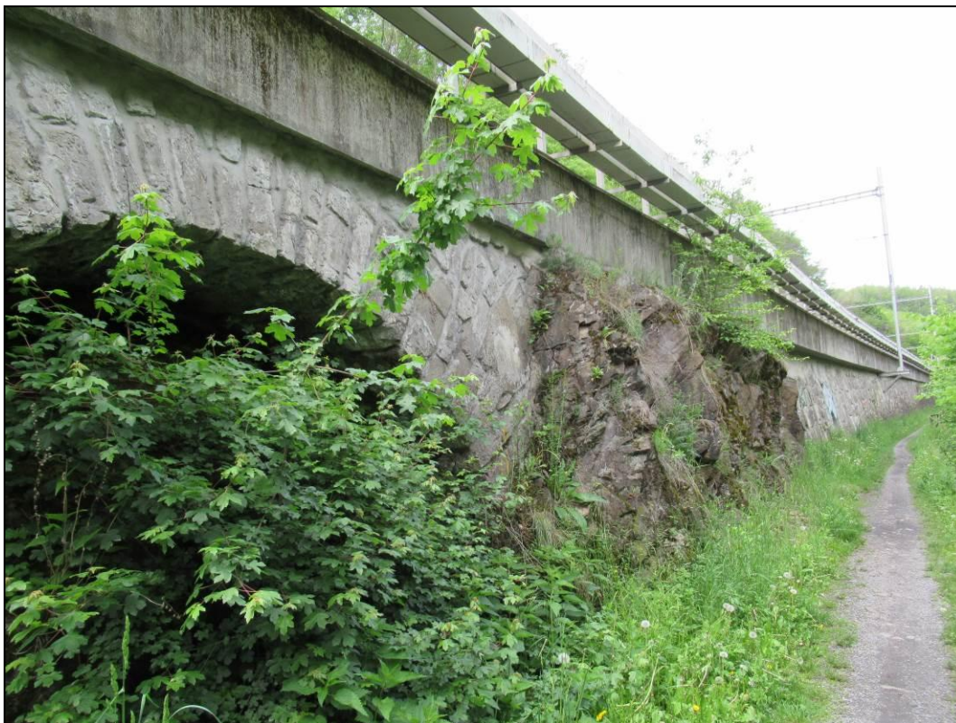
Obr. č. 19 - pohled na objekt opěrné zdi po směru rostoucího staničení od km ca 165,280 do km ca 165,360. Za skalním výchozem v km 165,295 - 165,305 je v líci patrný propustek v km 165,317 (evidován v km 165,308). Dřík zdi je za skalním výchozem až do konce OZ opět z kamenného zdiva.
