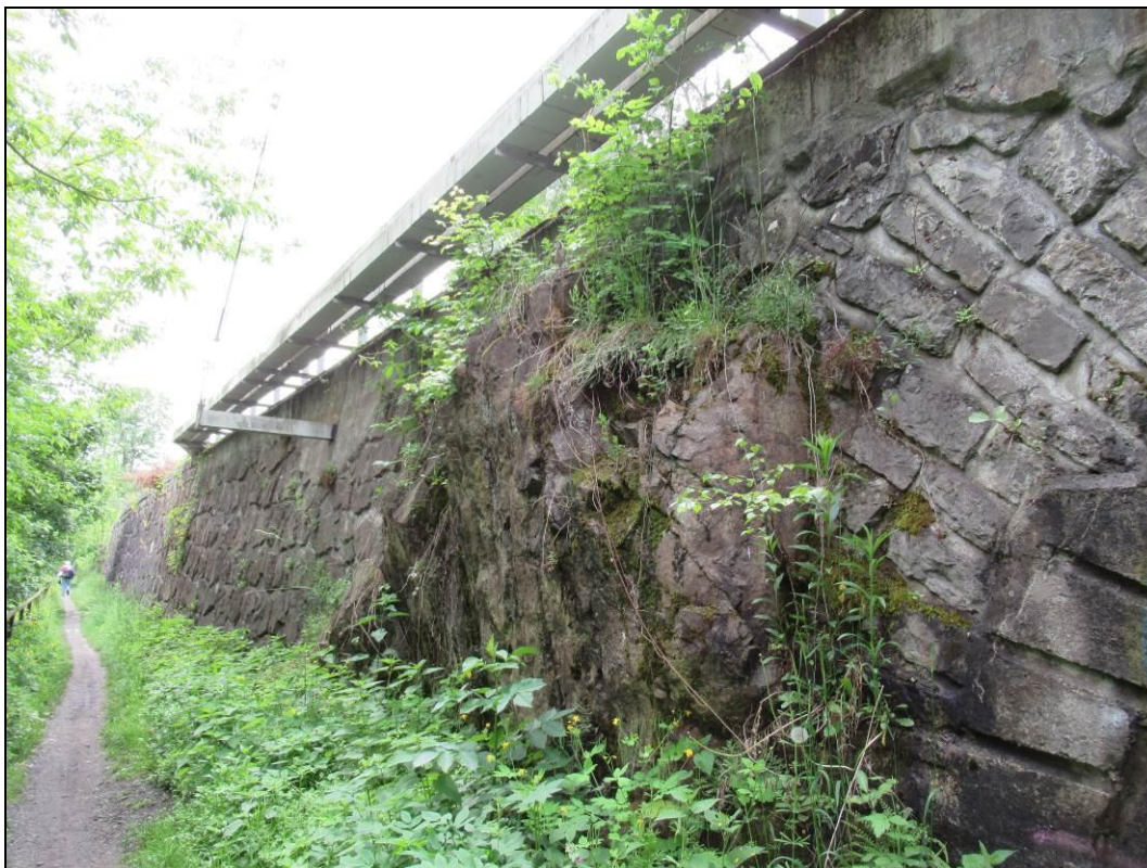
Obr. č. 17 - pohled na objekt opěrné zdi proti směru rostoucího staničení od km ca 165,240 do km ca 165,280. Od km ca 165,265 je v koruně zdi po přimknutí OZ k trase trati opět betonová římsa. V km 165,265 - 165,275 je v líci skalní výchoz.
